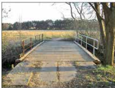
Brücke am Feldweg nach Kersdorf
