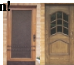
... vor der PORTAS- Renovierung
