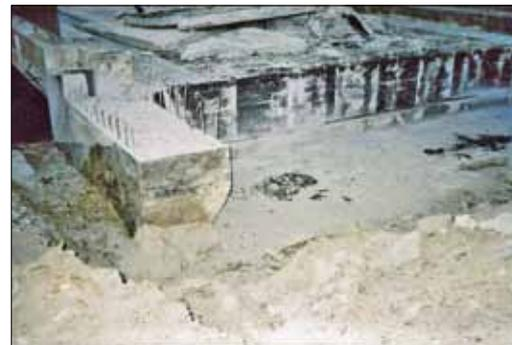
Katharinengraben-Brücke Fundament einer Panzerbrücke aus dem Jahre 1988 wurde bei Neubau der Brücke 2006 belassen und ermöglicht nur 1,50 Meter Durchfahrthöhe
