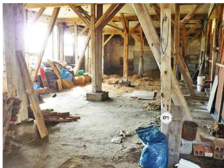
baulicher Zustand vor der Sanierung (links)
