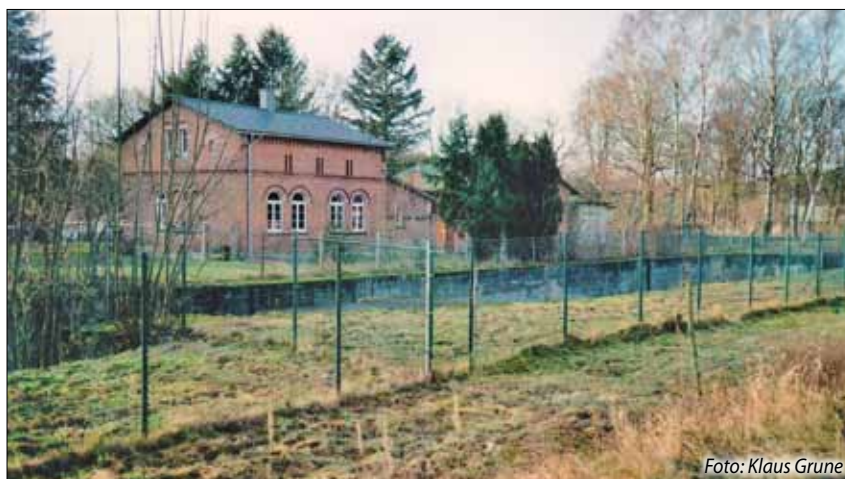
Schleuse und frisch saniertes Schleusenhaus „Schlaubehammer“
